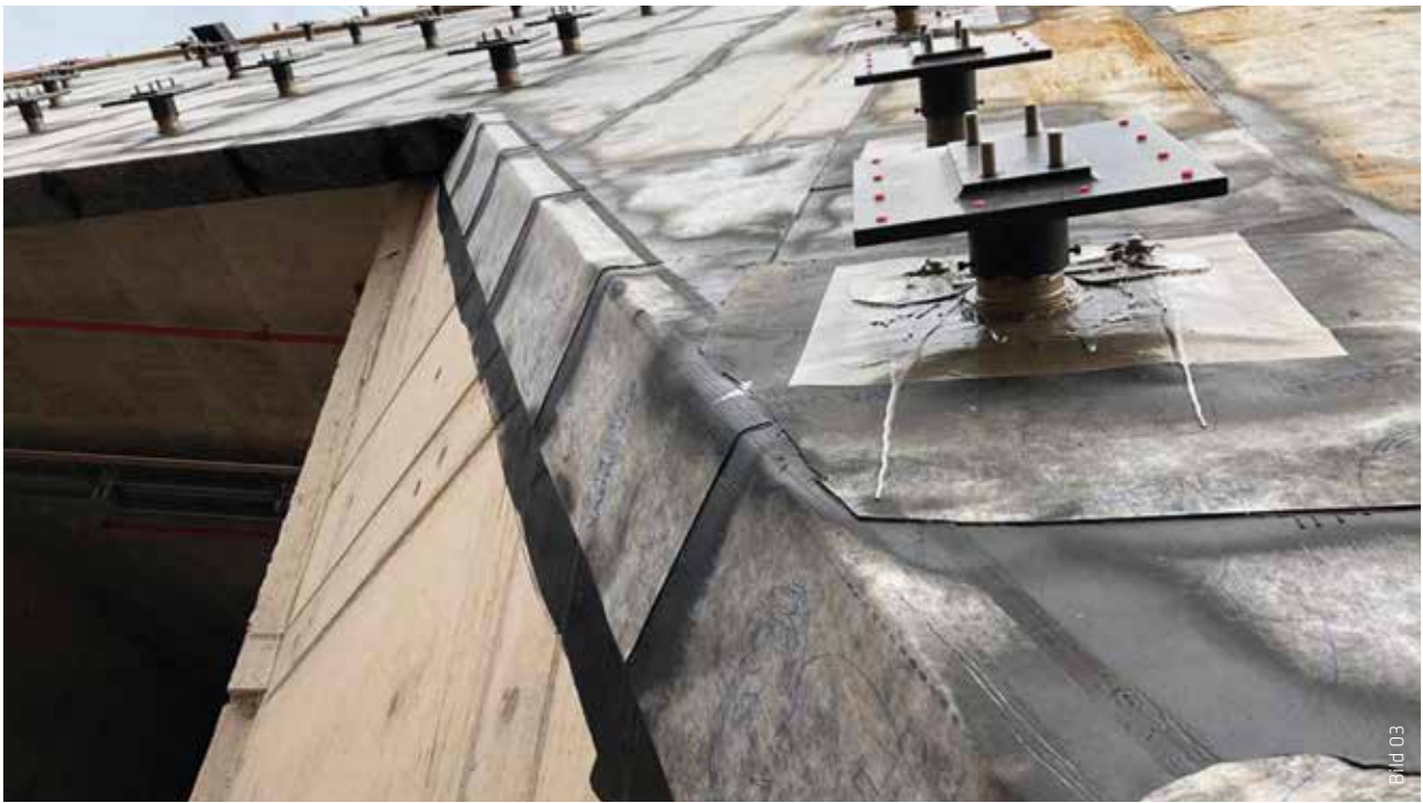
Das Geschäfts- und Bürohaus KII in Düsseldorf mit Europas größter Grünfassade. Das Sarnafil® System von Sika ermöglicht die langfristige Dachabdichtung der außergewöhnlichen Konstruktion.
